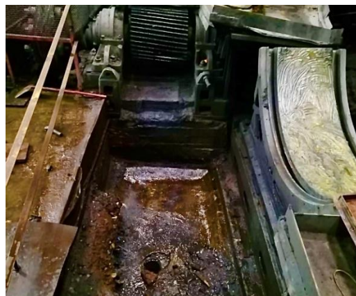
Рис. 3. Выполнение ремонтных работ по восстановлению вкладышей подшипника скольжения мельницы мокрого самоизмельчения ММС-70×23 «Гидрофол»
